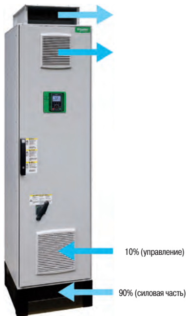
Система охлаждения с разделением потоков воздуха
